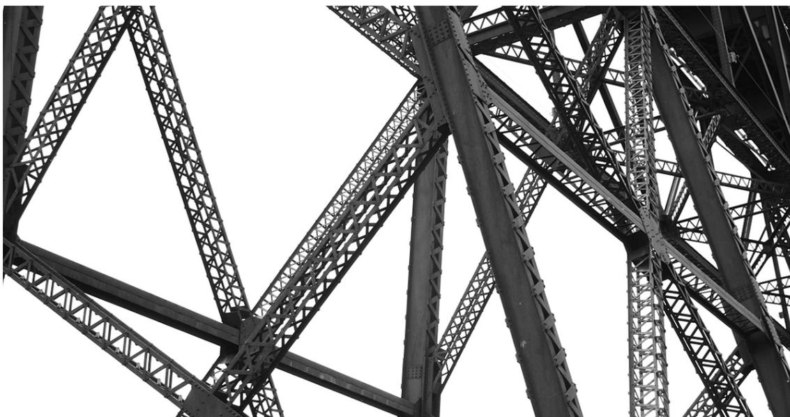
Figura 2.7 - Exemplo de uma viga de rede aberta
