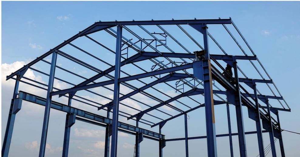
Figura 2.8 - Exemplo de uma viga continuamente suportada
